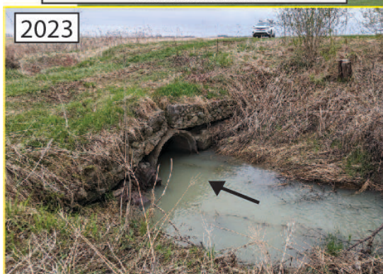
Mesure # 2 Remplacement d'un ponceau sous-dimensionné
