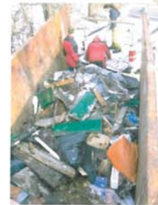
Nettoyage des berges
